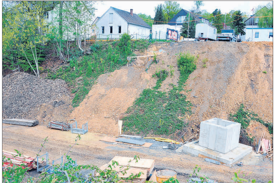
Das Fundament für den Stützpfiler der Fußgängerbrücke, die nächste Woche kommt, wurde gestern fertiggestellt. (Fotos: Schmittgen)
